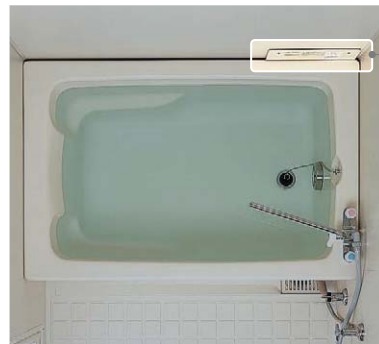
取替後 | 壁貫通タイプ
