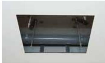
2 買替アダプターを取り付けるための吊ボルト(現地調達)を設置します。
